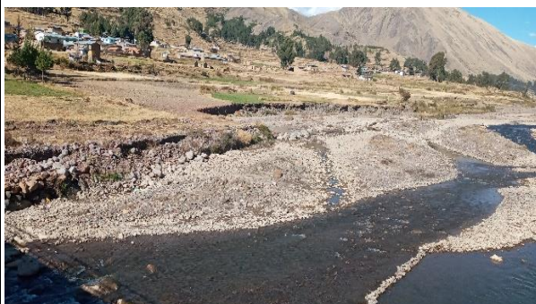
FOTO 03 y 04: Se aprecia el curso del agua por la margen izquierda afectada por la ribera con erosión y próximo la infraestructura de la línea férrea, localidad del distrito de Marangani.
